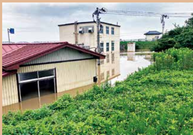
横根山揚水機場水没状況
