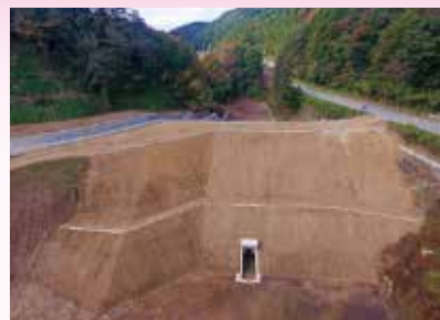
柳沢ため池 堤体
