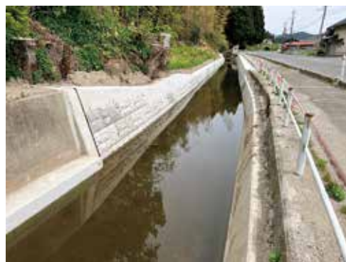
改修された大型ブロック積水路
