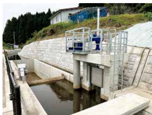
新設された自動転倒ゲートと分水ゲート
