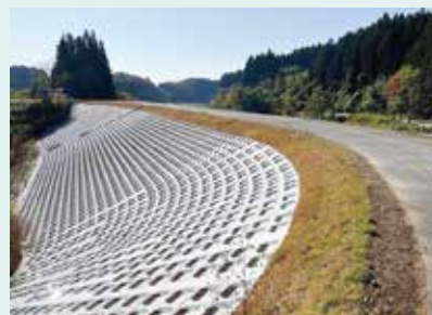
金谷ため池 堤体
