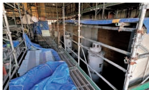
仮設足場に囲まれ稼働中の揚水機
