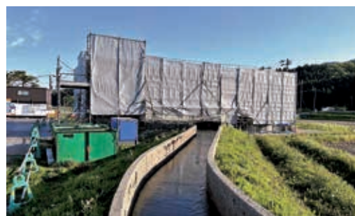
建屋整備補修工事中の揚水状況
